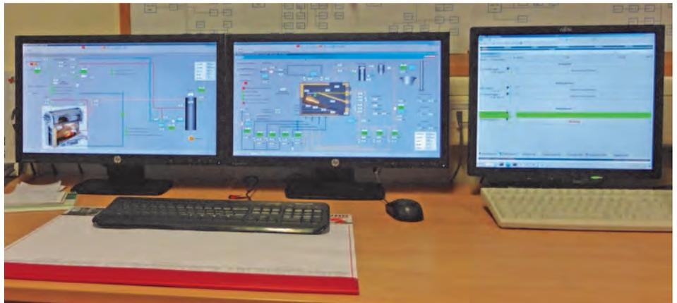
Aus einer modernen Leitwarte wird das Schnitzelwerk und die Energieversorgung des Fliegerhorstes gesteuert.
