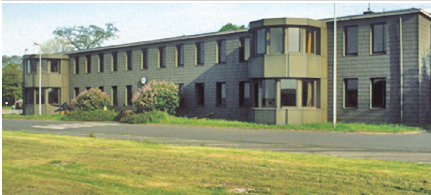
Gebäude 43 (kurz vor dem Abriss im Jahre 2012!!)
