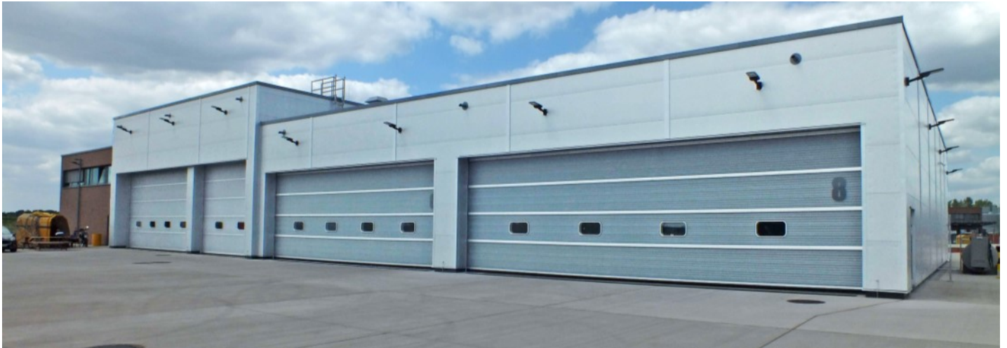
Seit kurzem die neue Heimat der Teileinheit Besonderer Fahrdienst – Die neue Halle 409.
