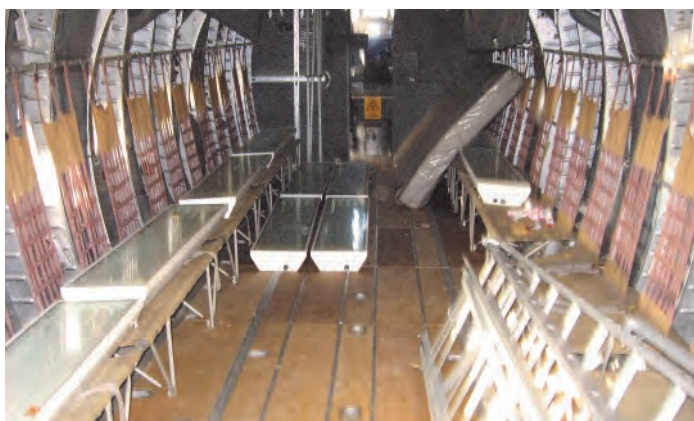
Der vorherige Zustand. Als Lager missbraucht. Die Deckenverkleidungen hängen herunter. Der Marder hat Schäden hinterlassen. Die Elektrik war hin und die Maschine war undicht geworden.
