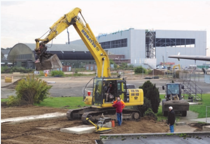
Die Standfundamente für die NORA sind gegossen.
