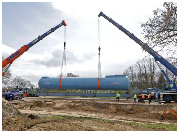
Zwei 300 Tonnen-Kräne für einen 64 Tonnen Tank.
