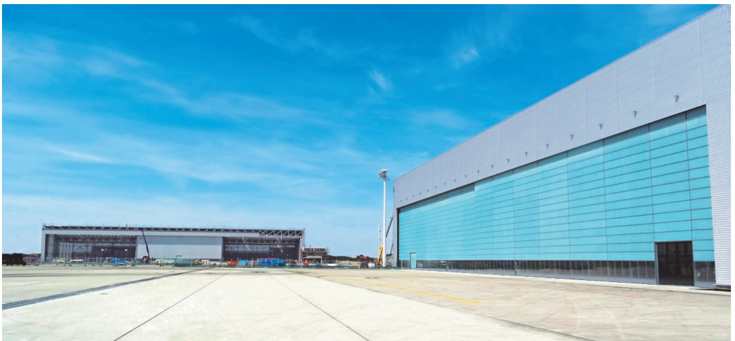
Ein gewaltiger Komplex im Westen des Platzes geht seiner Vollendung entgegen: Wartungs- und Waschwahlle für drei A400M, Länge 180m, Tiefe 80m. Instandsetzungshallen für vier A400M, Länge der gesamten Anlage 260m und 26m hoch.
