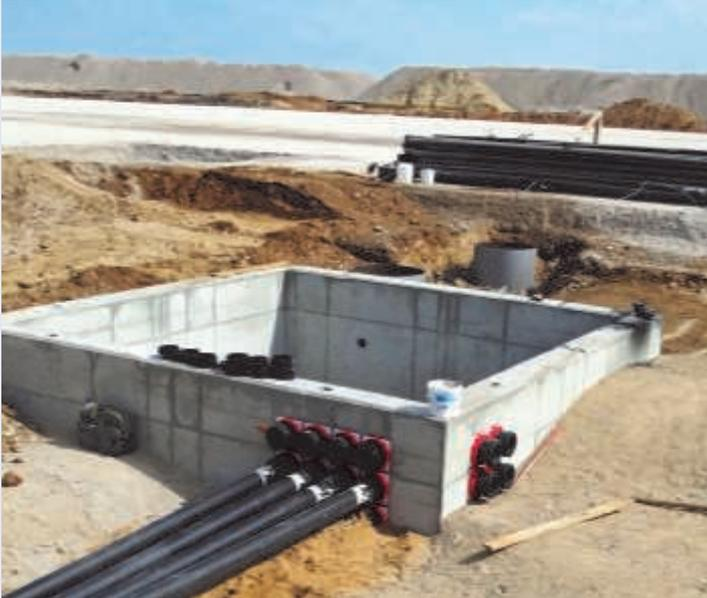
Aus dem Versorgungsschacht bezieht der A400M Daten, Hydraulik und Strom.
