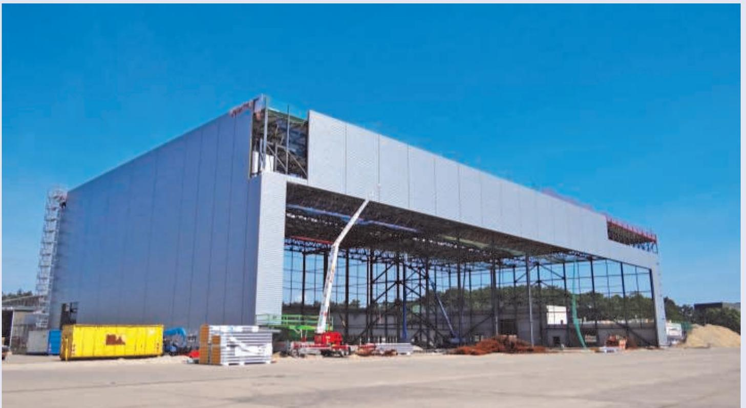
**Die erste Hälfte der Instandsetzungshalle wird bereits verkleidet. Nach Abriss der Halle 7 folgt daneben der Bau des zweiten Hallenteils.**
