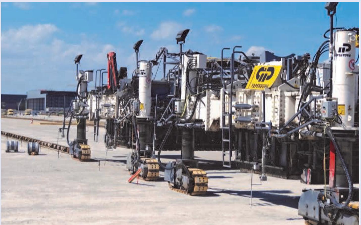
Der Betonunterbau für die Ramp ist fast einen Meter dick. Schon stehen die Betoniermaschinen bereit um die Abschlussbahnen der Ramp aufzubringen.
